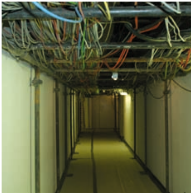
Umbau in vollem Gange
